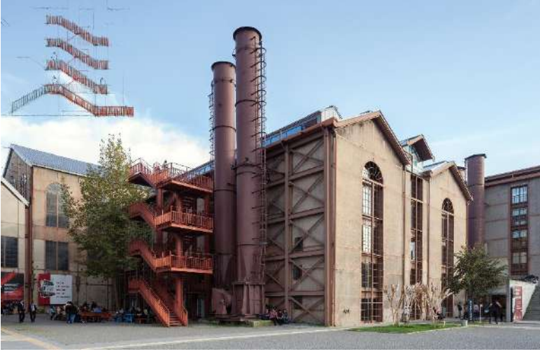
Şekil 4. Silahtarğa elektrik santrali (NZMH)
