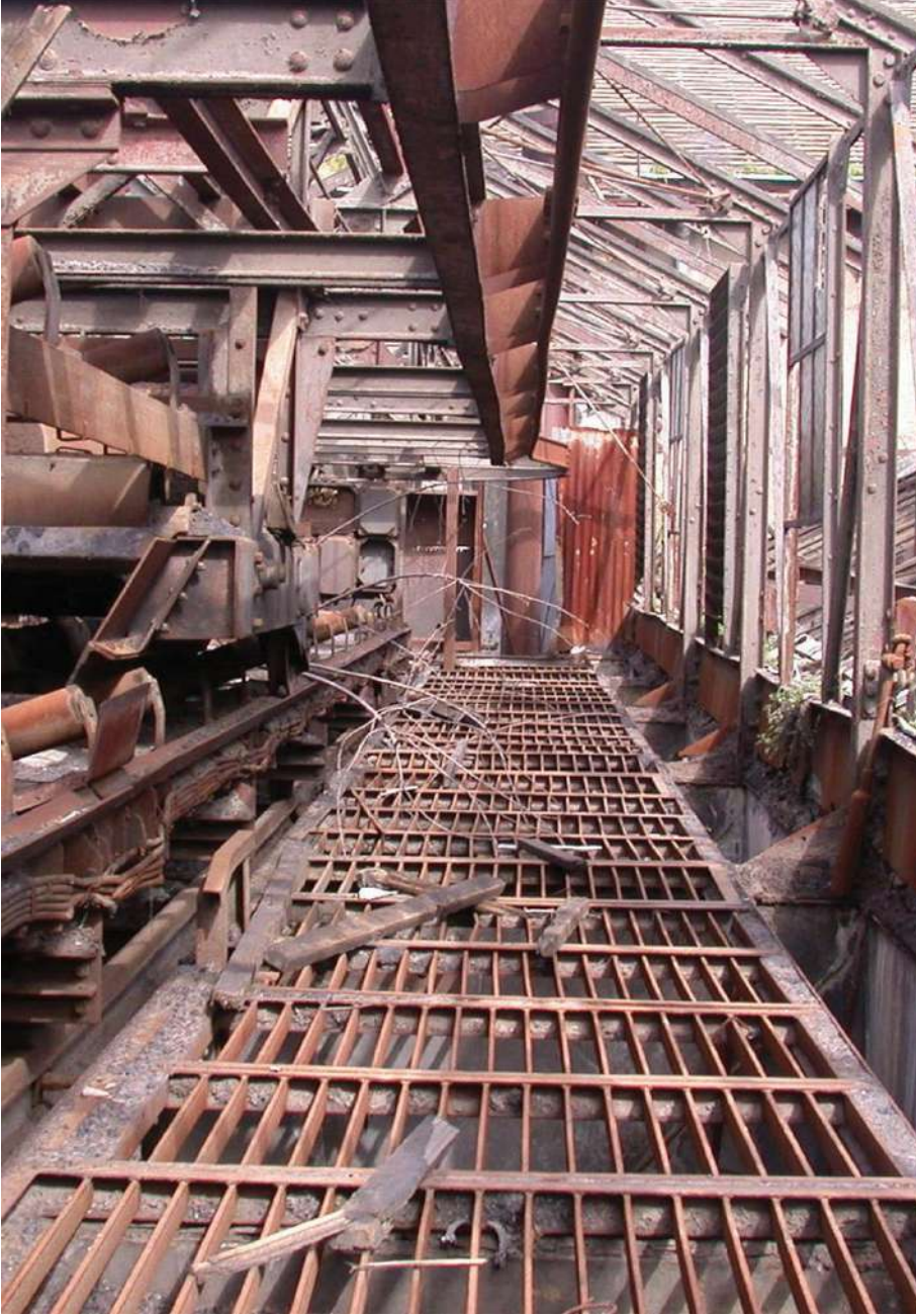
Şekil 5. Silahtarağa elektrik santrali içi restorasyo öncesi (NZMH)
