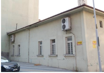
Fotoğraf 4: Tahtalı Minare Camii pencereler dıştan görünüm
