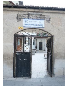
Fotoğraf 2: Tahtalı Minare Camii Avlu giriş kapısı
